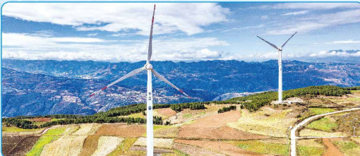
云南寻甸一期风场
