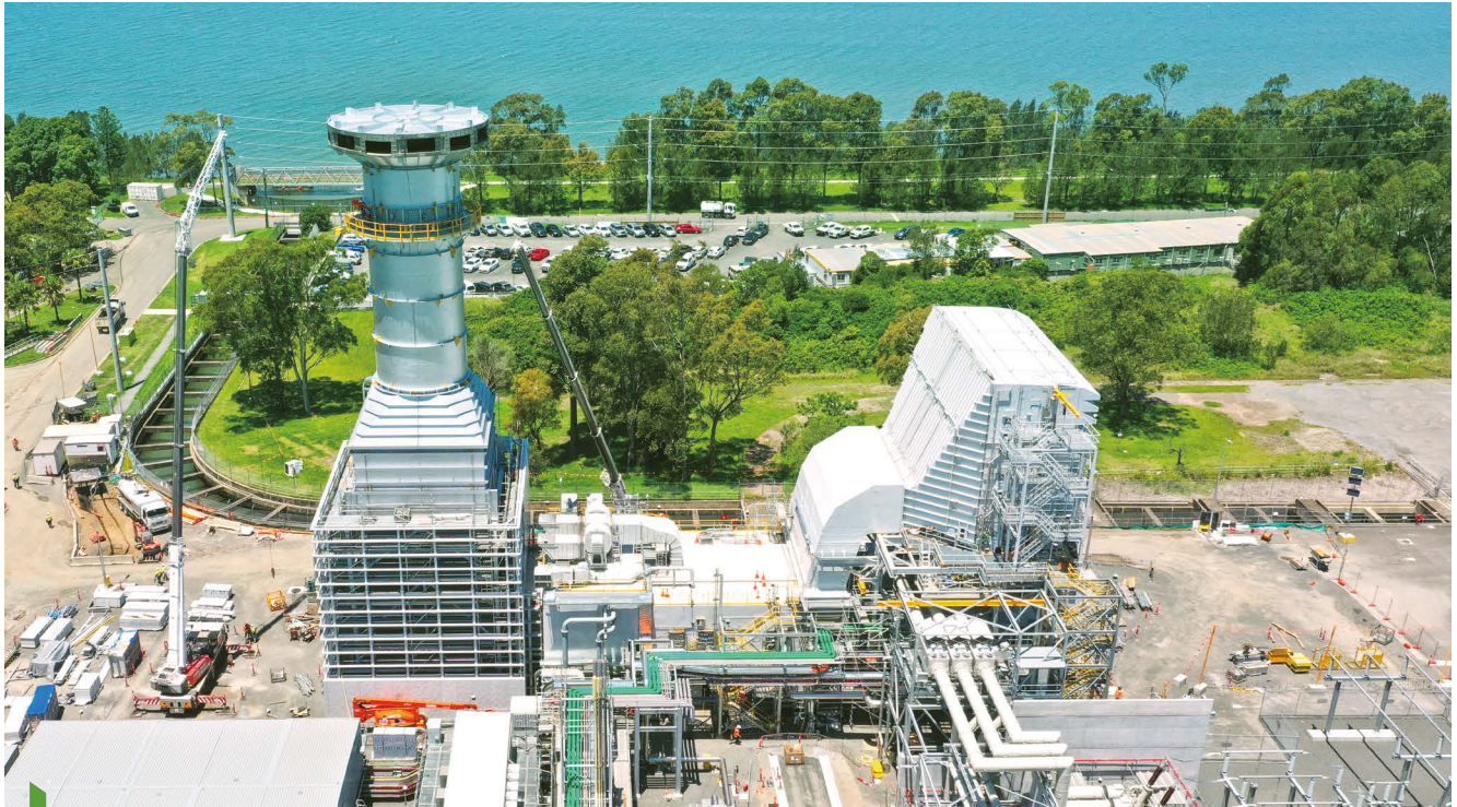
新建的320兆瓦Tallawarra B電廠屬快速啟動的燃氣發電資產，在用電高峰期間及日照和風力不足時，將在供電方面發揮關鍵作用。
